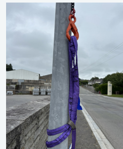
Passage de l'élingue dans le crochet de levage
