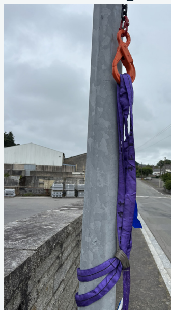
Passage de l'élingue dans le crochet de levage
